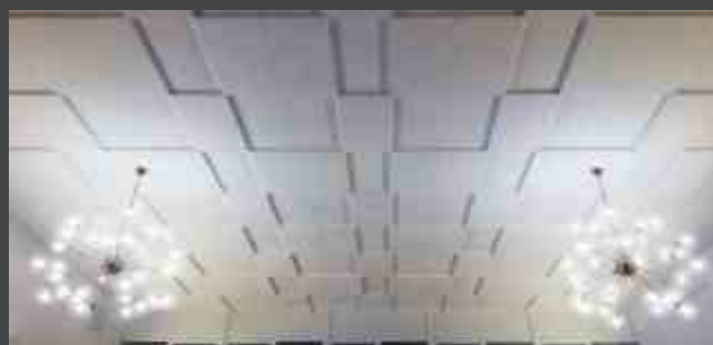
Ukážka stropnej realizácie panelov Modular uchyťované na bočné klipy
