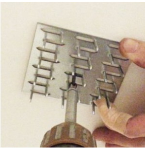
Uchytenie „ježka“ skrutkou (horizontálne)
