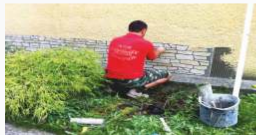
Došpárovanie a čistenie detailov
