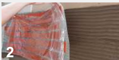
2 Položíme plát Dekobriku s fóliou do tmelu
