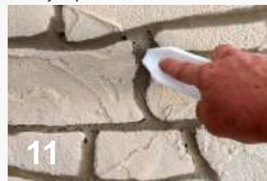
11 Zahľadanie vlniek po fólii vyrezaným polystyrénom namáčaným vo vode
