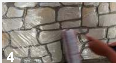
4 Fóliu napneme a valcom silne zatlačíme plát
