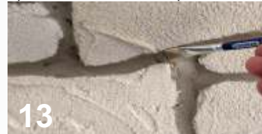
13 Dohľadanie povrchu špár mokrým štetcom
