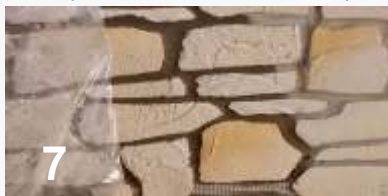
7 Po min.4 hod fóliu dáme dole a dohľadíme resp.došpárujeme miesta s dierou,vlnkami
