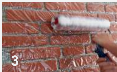
3 Fóliu napneme a valcom silne zatlačíme plát
