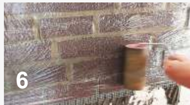
6 Fóliu napneme a valcom silne zatlačíme plát
