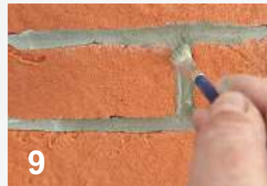
9 Oprava špáry štetcom
