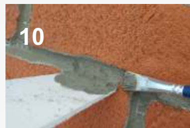
10 Vtláčanie suchšieho tmelu do špár na zakrytie mriežky resp. dier.
