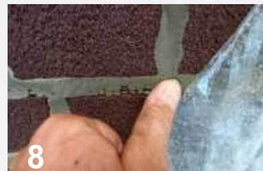
8 Oprava špáry prstom
