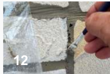
12 Oprava dier a vlniek štetcom po min. 4hod
