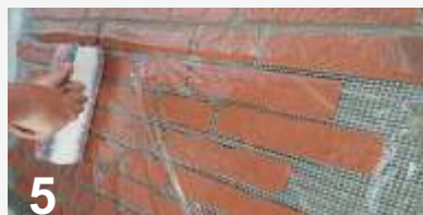
5 Fóliu napneme a valcom silne zatlačíme plát
