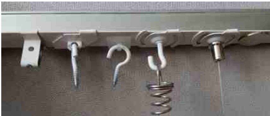
Možnosti vešania panelov na T profily s úchytmi a magnetom.
