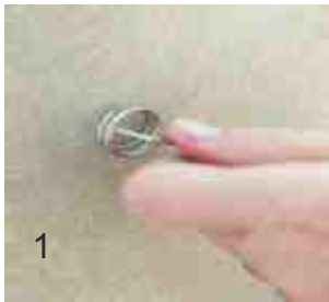
1 Zakrútenie drôteného háku do tela MV panelu
