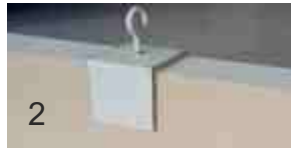
2 Vešanie panelov na T profily s posuvnou roztečou medzi panelmi. Rozteč medzi T profilmi je 60 alebo 120 cm. Na strop sa vešajú len T profily-
