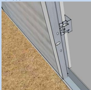
Zatlačanie T profilov do závesov
