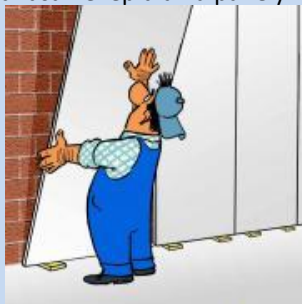
Zatlačenie panelu o stenu
