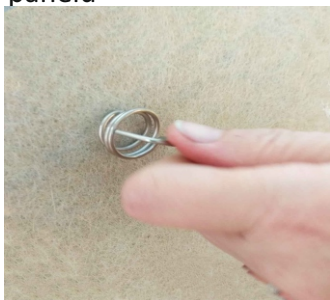
Zakrútenie drôteného háku do tela MV panelu
