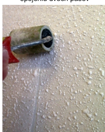
Zatlačanie Dekorty do lepidla gumeným valcom
