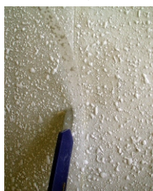
Dvojitý rez k bezošvému spojeniu dvoch pásov
