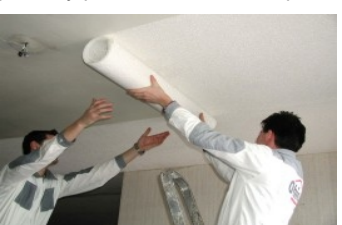
Odvalovanie rolky po vrstve lepidla na strope
