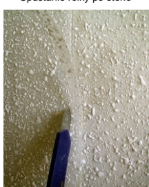
Dvojitý rez k bezošvému spojeniu dvoch pásov
