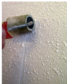
Zatlačanie Dekorty do lepidla gumeným valcom
