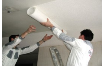
Odvalovanie rolky po vrstve lepidla na strope
